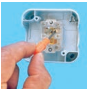
د - برقراری اتصال پلاتین با کنتاکت غیر مشترک ۲
