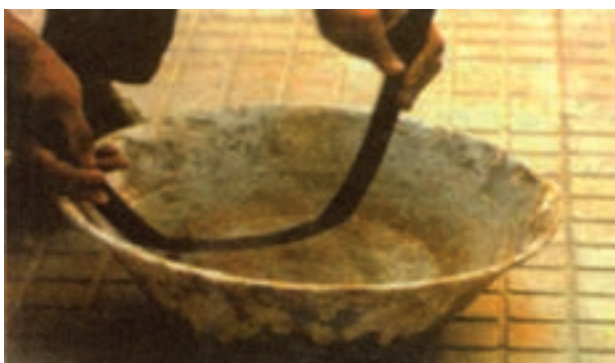
شکل ۴-۴۵ - سرد کردن لوله پس از خم‌کاری
