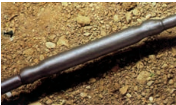
ج- وضعیت روکش پس از عملیات
