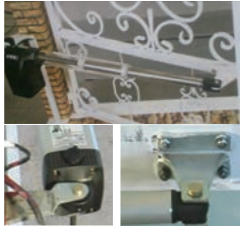
شکل ۴۸-۴ محل اتصال موتور به چارچوب در و لنگه در
