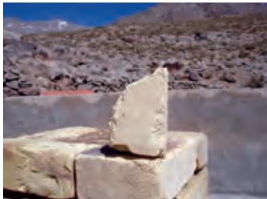
۳۰- برای شروع رج سوم نیاز به جزء آجر مطابق شکل ۱-۵۱۸ می باشد و نمی توان اندازه‌ی دقیقی برای آن نوشت و اندازه‌ی آن را در حین کار باید برداشت کرد.
