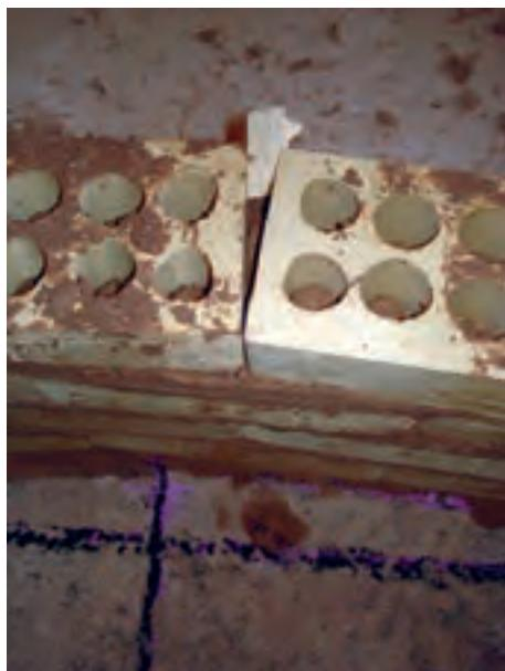
۶۰- بین آجرها بند ایجاد شده و باید از بند انگشتی استفاده کنید. مطابق شکل ۱-۵۹۸
