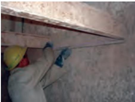
۹- با گچ تحریر از بالای شمشه یک خط مستقیم بین دو تیرآهن رسم کنید (نقطه A تا B). مطابق شکل ۱-۵۴۴
