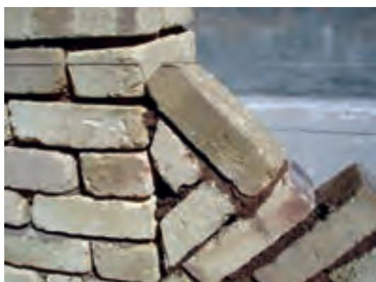
۳۲- ملات را پهن کنید و آجرهای بعدی را در جای خود قرار دهید. با نصب آجر کامل اول رج سوم ارتفاع از زمین تا بالاترین نقطه آجر نصب شده را مشخص کنید و روی ستون مقابل مشخص کنید و ریسمان کار را ببندید. مطابق شکل ۱-۵۲۰
