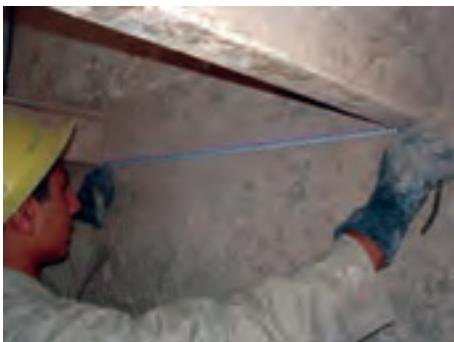
۱۰- طول دهانه را با متر اندازه بگیرید (نقطه A تا B). مطابق شکل ۱-۵۴۵
