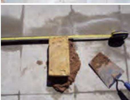
۷- مطابق شکل ۱-۳۳۳، محل آجر انتهای دیوار را با رعایت اندازه مطابق نقشه کار مشخص کنید.
