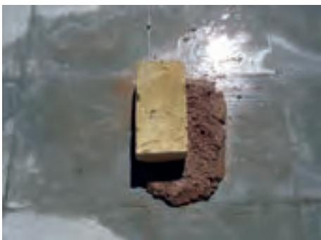
۳- مطابق شکل ۱-۳۲۷، آجر ابتدای دیوار را در محل مناسب قرار داده و با استفاده از تراز به صورت ضربدری سطح آن را تراز کنید.
