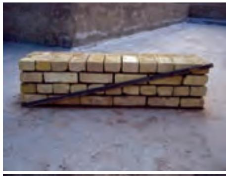
۳۴- پیچیدگی کار را توسط شمشه به صورت ضربدری در جلو و پشت دیوار کنترل کنید. مطابق اشکال ۱-۴۰۷ و ۱-۴۰۸
