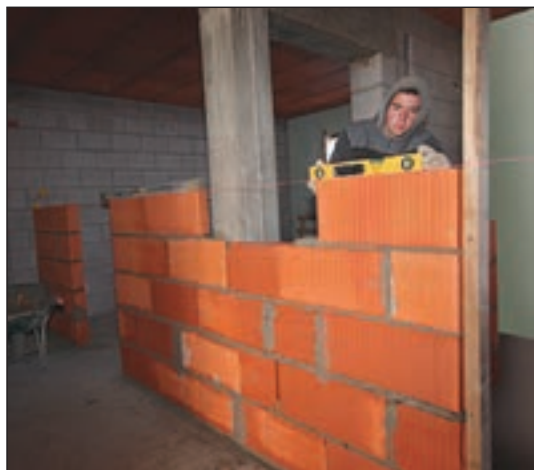
شکل ۱-۱۰۹ دیوار غیرباربر بلوک سفالی
