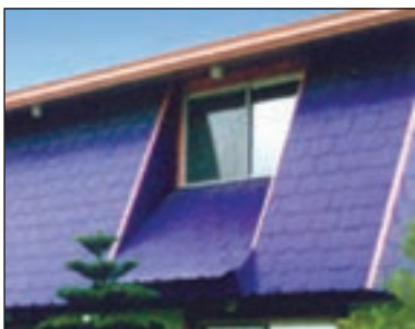
شکل ۴۷-۱ پوشش نهایی سقف شیب‌دار با آردواز
