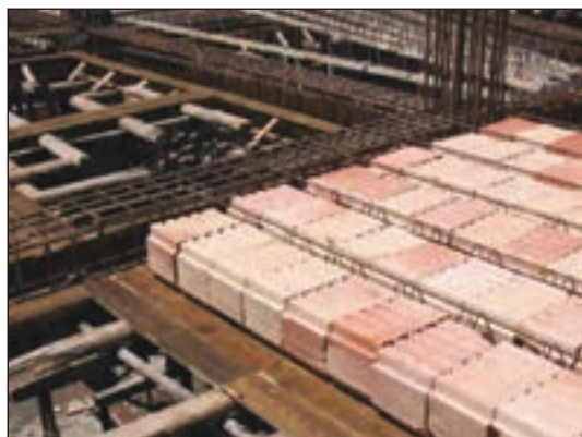
شکل ۱-۱۵۲ کاربرد بلوک سفالی در سقف
