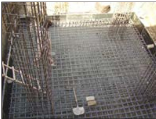
شکل ۱۵۱-۲ آرماتورگذاری پی صفحه‌ای با ستون‌های بتنی
