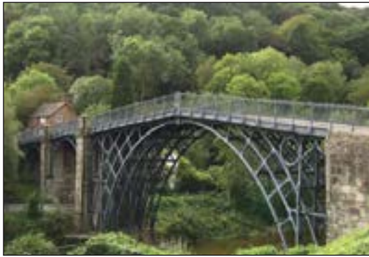
شکل ۱-۲ پل رودخانه سورن در انگلستان
