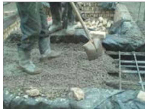
شکل ۲-۱۴۵ مرحله ی بتن ریزی داخل پی
