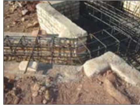
شکل ۲-۱۴۳ آرماتورهای شناژ و پی
