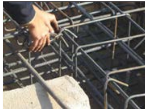
شکل ۲-۱۴۱ بستن خاموت دور آرماتور اصلی شناژ
