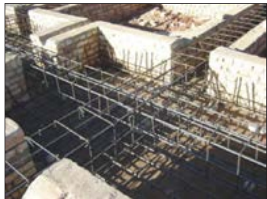
شکل ۷۱-۲ عبور میلگردهای شناژ در پی
