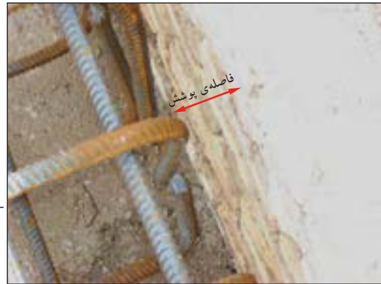
شکل ۱۲۶-۲ فاصله‌ی پوشش و قلاب سر میل‌گردها
