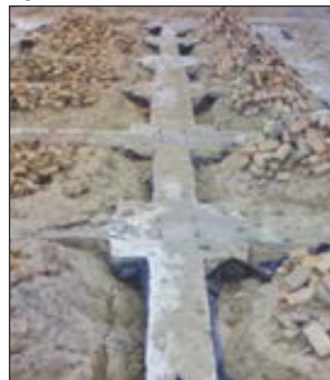
شکل ۷۳-۲ پی و شناژ بعد از بتن ریزی
