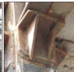
اتصال تیر به ستون به صورت لچکی
