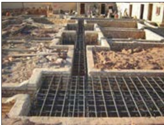
شکل ۷۰-۲ میلگردگذاری در پی کلاف بندی
