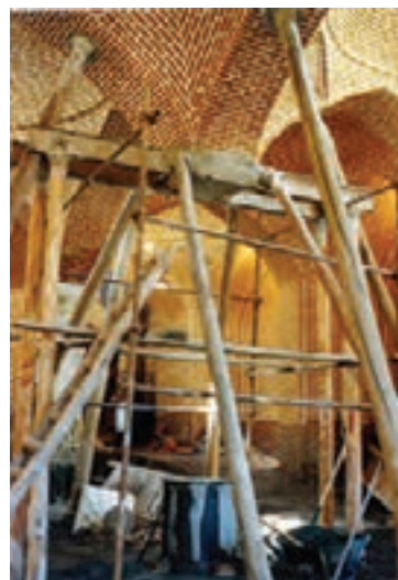
▲ شکل ۴-۶۷ چوب به عنوان عنصر کمکی برای تقویت سازه
