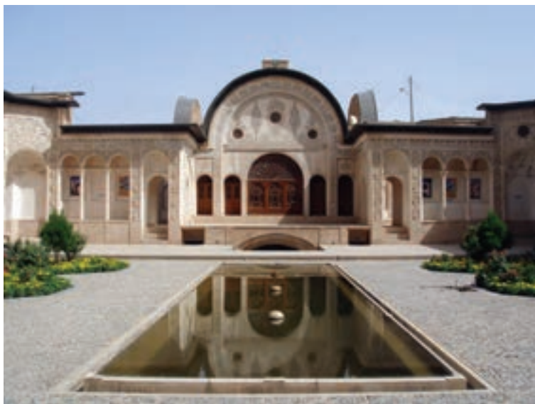
شکل ۲۶-۴ خانه طباطبایی‌ها در کاشان (قوس نیم دایره)
