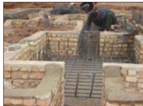
شکل ۱-۸۲ قالب‌بندی آجری در اطراف پی
