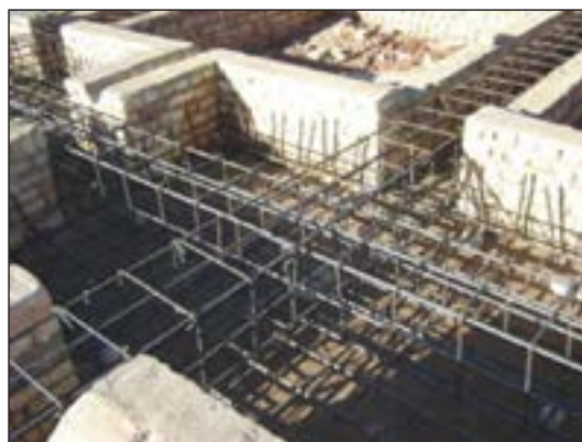
شکل ۲-۷۱ عبور میلگردهای شناژ در پی
