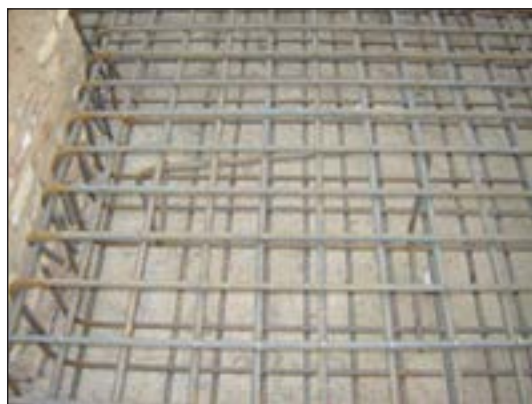
شکل ۱۴۷-۲ پی نواری و آرماتورگذاری آن
