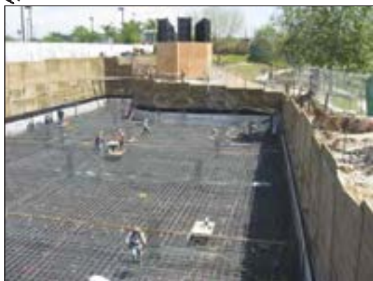
شکل ۱-۶۲ پی بتن مسلح یکپارچه (رادیه ژنرال)
