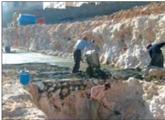
شکل ۸۷-۱ گودبرداری دستی (با بیل و کلنگ)
