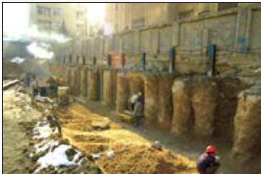
شکل ۸۸-۱ مهاربندی با پشت بند خاکی ستونی
