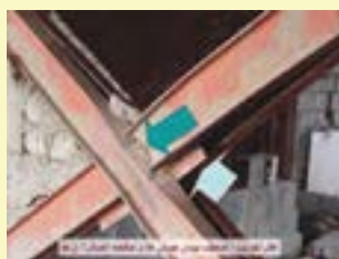
ضعیف بودن جوش و عدم اتصال مناسب
