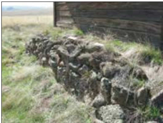
شکل ۱-۳۲ پی سنگی با سنگ لاشه
