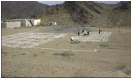
شکل ۸۳-۱ پیاده کردن نقشه روی زمین
