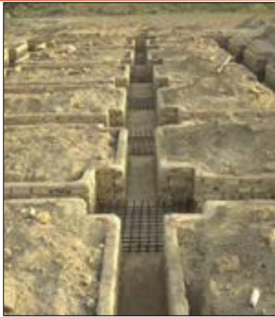
شکل ۴۸-۱ آرماتورگذاری پی تکی کلاف بندی شده
