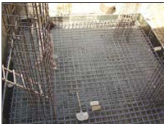
شکل ۱۵۱-۲ آرماتورگذاری پی صفحه‌ای با ستون‌های بتنی
