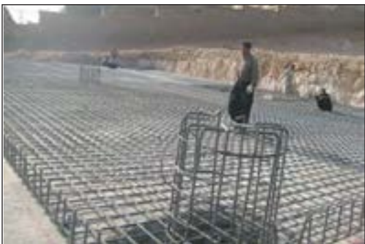
شکل ۱۵۲-۲ آرماتورگذاری پی صفحه‌ای با ستون‌های بتنی
