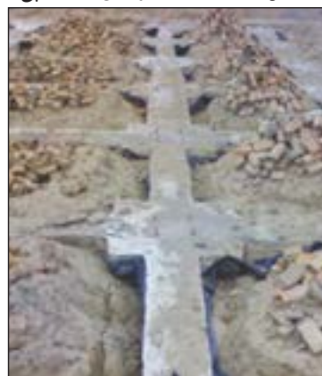
شکل ۲-۷۳ پی و شناژ بعد از بتن ریزی
