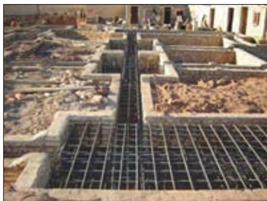
شکل ۲-۷۰ میلگردگذاری در پی کلاف بندی
