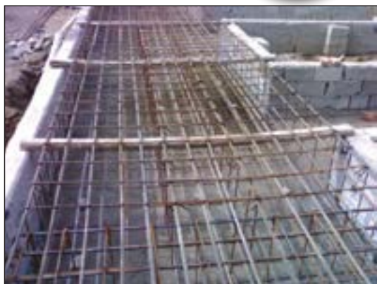
شکل ۱۴۶-۲ پی نواری و آرماتورگذاری آن
