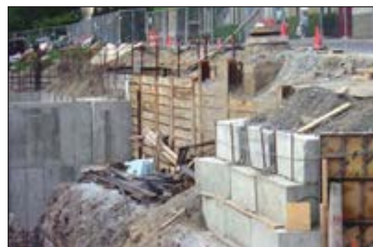
شکل ۹۱-۱ مهاربندی با دیوار مانع چوبی
