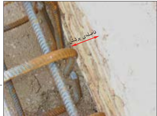
شکل ۲-۱۲۶ فاصله‌ی پوشش و قلاب سر میل‌گردها
