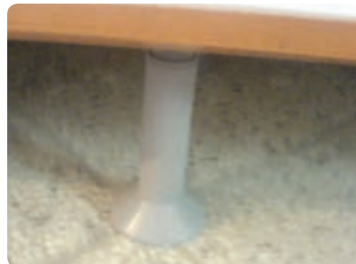
شکل ۶-۶۴ پایه نصب شده در زیر کابینت
