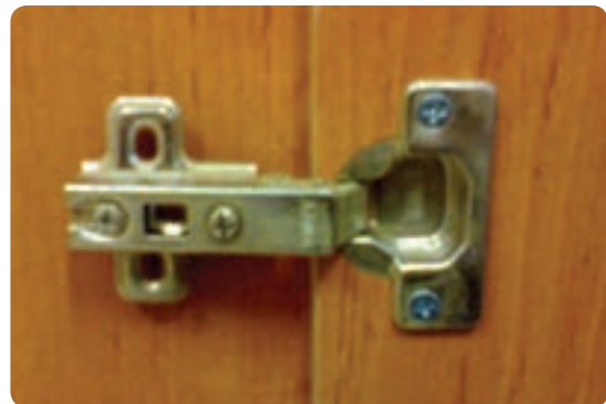
شکل ۶-۸۵ نصب کاسه لولا روی در کابینت
