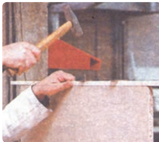
شکل ۶-۷۸ نصب زهوار چوبی لبه چسبان
