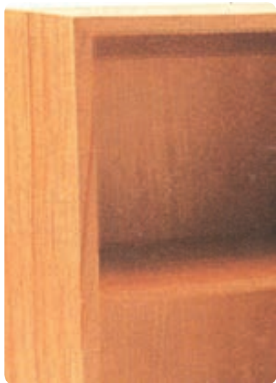
شکل ۶-۷ سقف و کف همرو با بدنه
