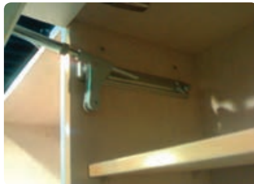
شکل ۶-۳۷ در کابینت نصب شده با نگه‌دارنده پمپی
