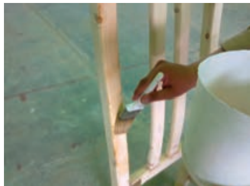
شکل ۳۶-۸- سیلکاری از سمت بالا به سمت پایین.
