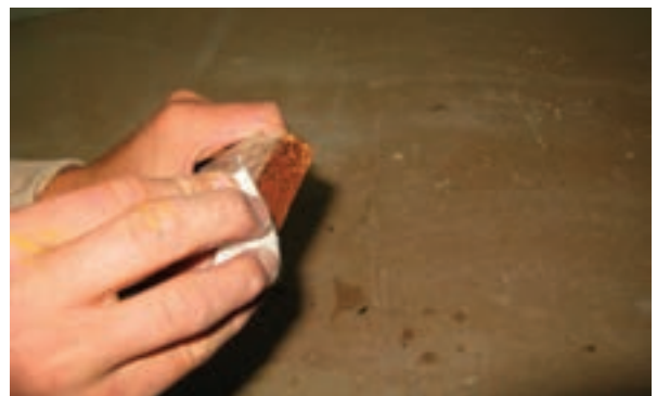
شکل ۶۴-۱۳- زدن آب به کله چوب.
