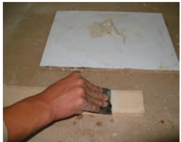
شکل ۵۹-۱۳- زدن بتونه هم‌رنگی به چوب نراد.
