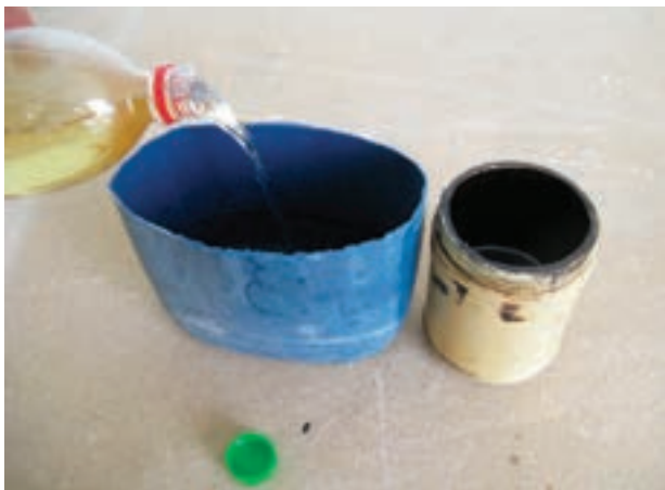
شکل ۴۵-۱۲- اضافه کردن نفت به آستری قیری.
