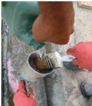
شکل ۴۳-۸- شستن پیستوله با ملال به کار رفته.
