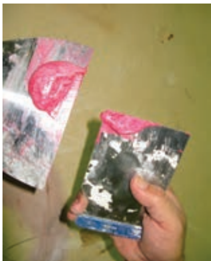
شکل ۲۷-۶- استفاده از لیسه و کاردک در بتونه کاری سطح کار با بتونه روغنی.
