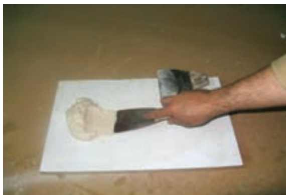
شکل ۱۸-۶- تخته بتونه برای سافت بتونه.
