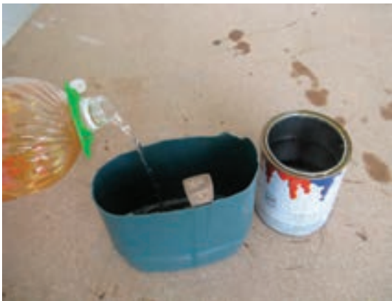
شکل ۶۶-۱۳- اضافه نمودن تینر روغنی به روغن جلا.
