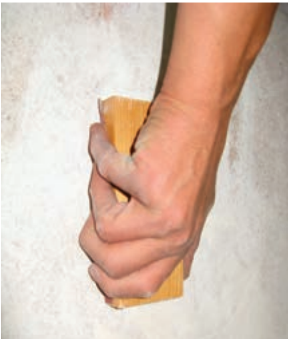
شکل ۱۹-۱۱- سنباده‌کاری سطوح ماستیک‌کاری شده.
