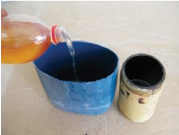
شکل ۴۴-۱۲- رقیق کردن آستری قیری با بنزین.
