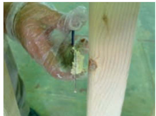
شکل ۶-۷- کاربرد بتونه سریشمی در سوراخ‌ها و شکاف‌های بزرگ.
