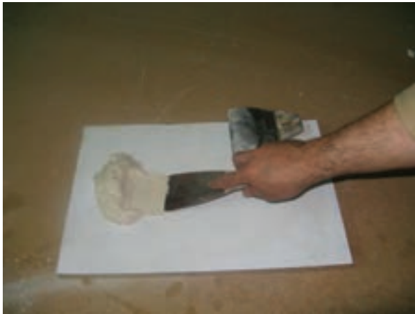
شکل ۱۸-۱۱- ماستیک‌کاری سطح کار.
