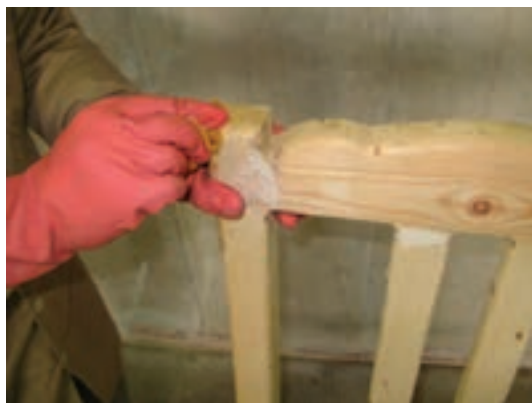
شکل ۳۱۴-۶- بتونه‌کاری غیر پوششی.
