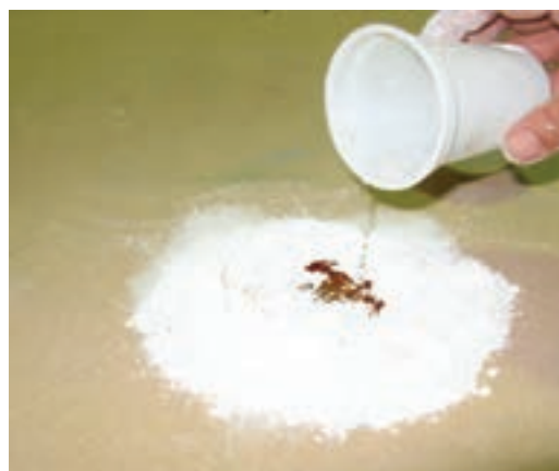
شکل ۲۳-۶- اضافه نمودن آب به بتونه روغنی.
