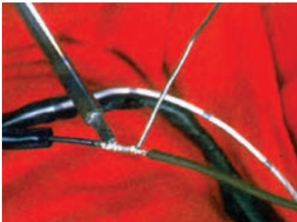
شکل ۱-۱۴۹- لحیم کاری محل اتصال سیم ها
