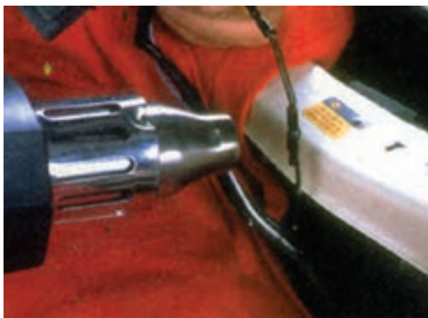
شکل ۱-۱۵۰- عایق کاری محل اتصال سیم ها
