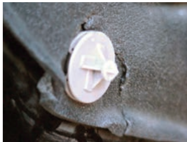
شکل ۲-۳۴- آسیب دیدن محل نصب خار در روی رودری
