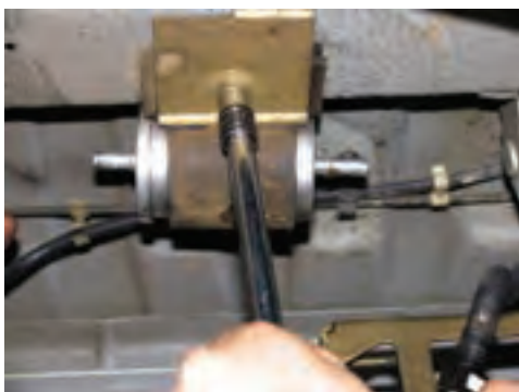
شکل (۲-۶۸) نصب فیلتر جدید
