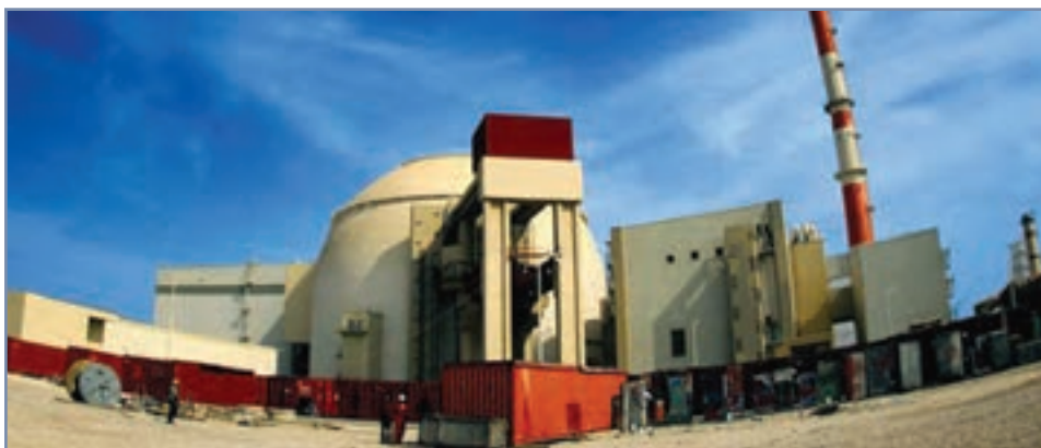
نیروگاه اتمی بوشهر
