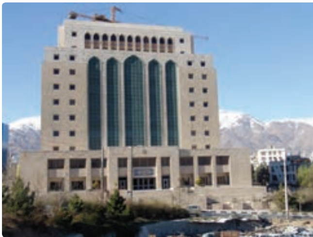
ساختمان گنجینه اسناد ملی
