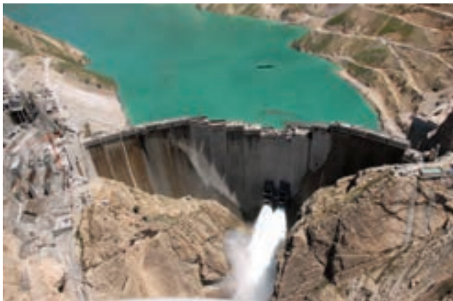
شکل ۶ - سد کارون ۴ - خوزستان
