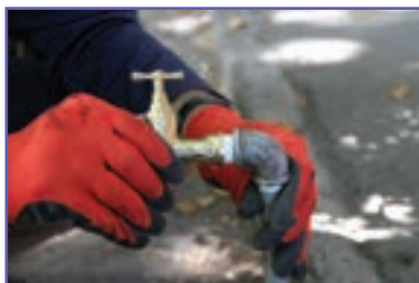
ت- بستن شیر با دست به لوله
