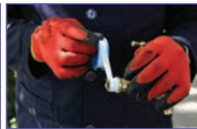
پ- پیچیدن نوار تفلون روی شیر نو
