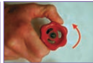
ح - باز کردن شیر فلکه اصلی
