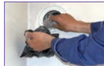
ب - فاصله بین دودکش تا کولر آبی و یا پ - برای خروجی دودکش هر دستگاه گازسوز یک کلاهک H نصب شود. دریچه های تأمین هوای ساختمان دست کم سه متر باشد.
