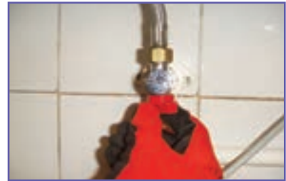
الف- بستن شیرهای آب گرم و سرد پیسوار زیر کاسه
