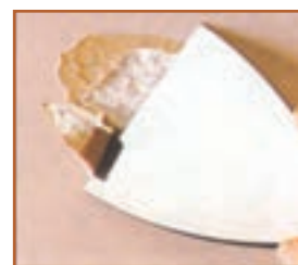
الف - باز کردن ترک‌ها
