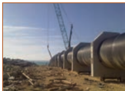
ت - احداث خطوط لوله
