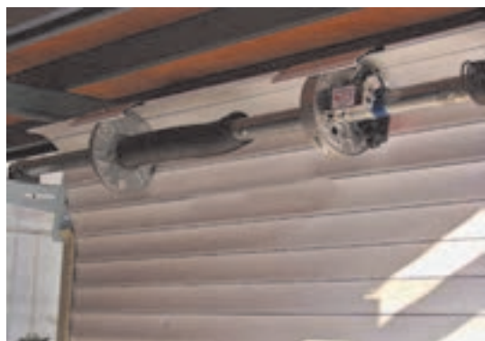
شکل ۱۱- محل نصب موتور کرکره‌ای
