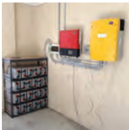
شکل ۶۱- اتصالات سیستم فتوولتاییک
