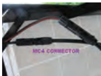
شکل ۲۸- اتصال کانکتور MC۴
