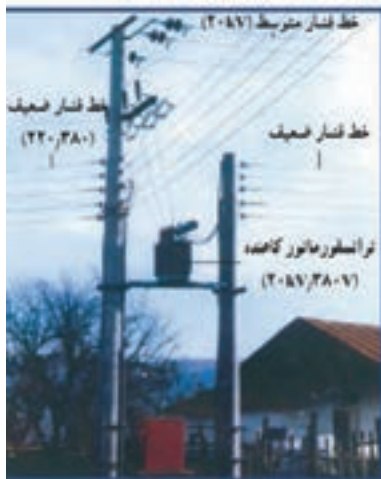
خطوط فشار متوسط و ضعیف هوایی برق
