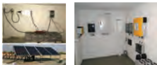
شکل ۴۶- اجرای دو نمونه سیم‌کشی سیستم فتوولتاییک
