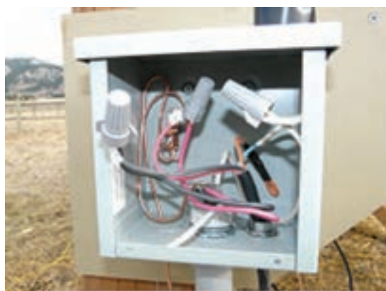
شکل ۳۵- اتصال میله مسی به بدنه تابلو اتصالات
