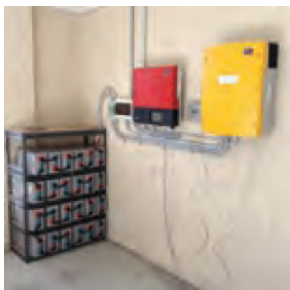
شکل ۶۱- اتصالات سیستم فتوولتاییک
