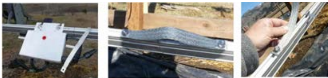
شکل ۲۹- همبندی در سامانه فتوولتاییک
