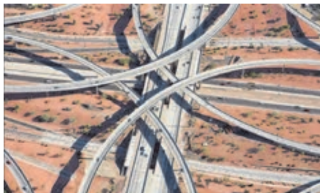
شکل ۲۷- تقاطع غیر هم‌سطح
