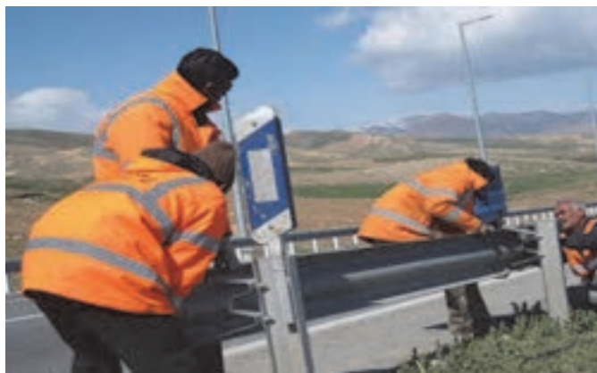
شکل ۷- نصب گاردریل کنار راه
