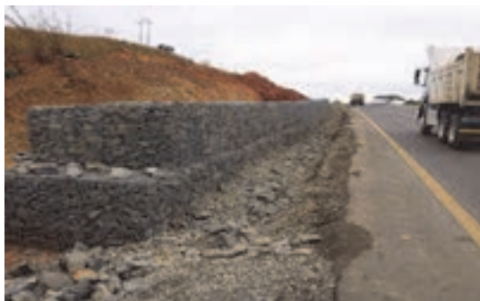
شکل ۱۰- دیوارهای گابیونی کنار راه
