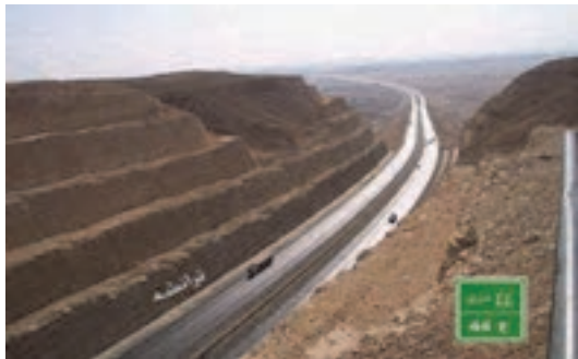
شکل ۹- ترانشه (شیروانی‌های خاکی اطراف راه)
