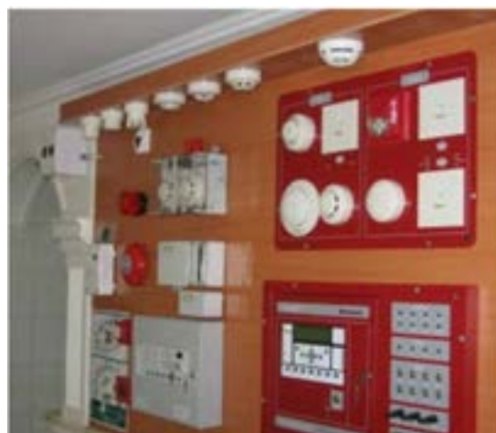
شکل ۹-۴: نمونه‌هایی از سیستم‌های اعلان حریق و کاشف‌ها
