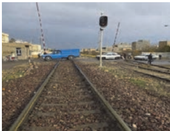
شکل ۱۴- تقاطع همسطح جاده و ریل
