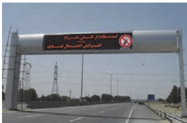
شکل ۱۶- نمایی از تابلوهای پیام متغیر
