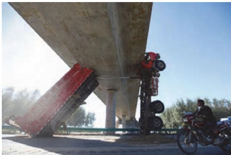
شکل ۶- نمونه‌هایی از برخورد کامیون با پل و تجهیزات پل
