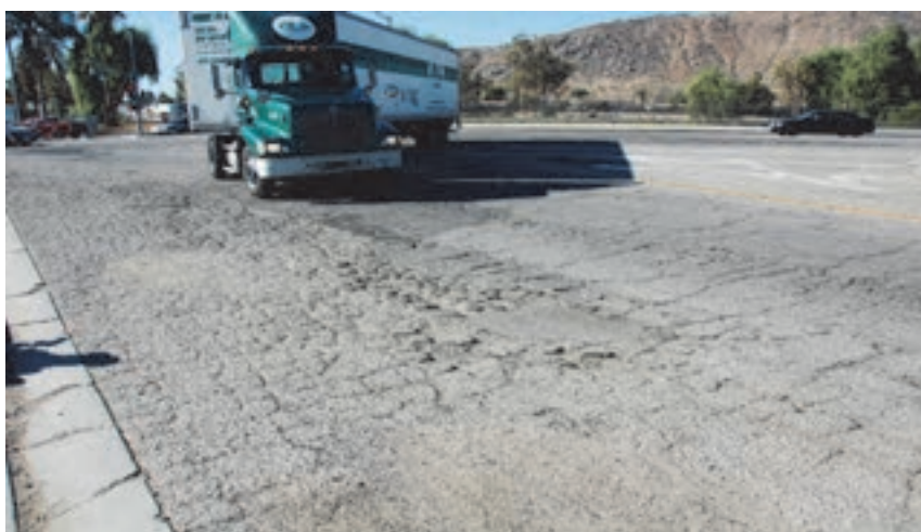
شکل ۱۲- نمونه‌هایی از خرابی‌های روسازی ناشی از ترمز یا وزن زیاد وسایل نقلیه سنگین
