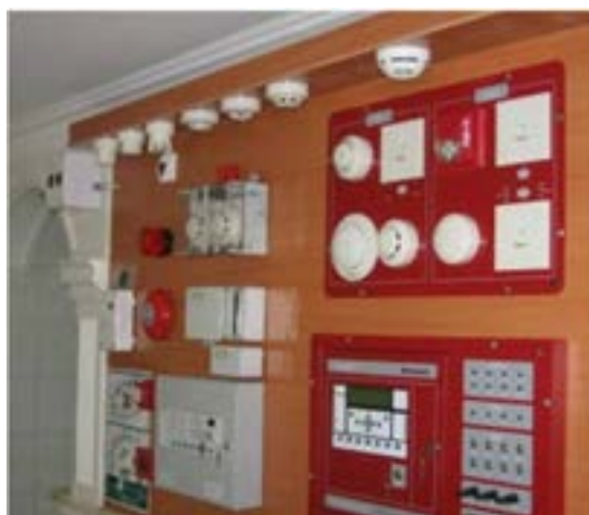
شکل ۹-۴: نمونه‌هایی از سیستم‌های اعلان حریق و کاشف‌ها
