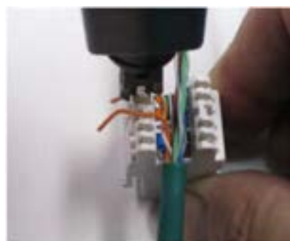
شکل ۱۹-۲- استفاده از یک نوع دستگاه پرچ
