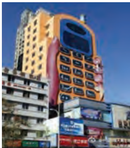
شکل ۱۱۰-۳- تصویر چاپ بر روی ساختمان
