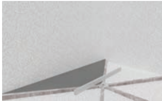
بتن ریزی بین کرم‌ها و تسطیح توسط شمشه
