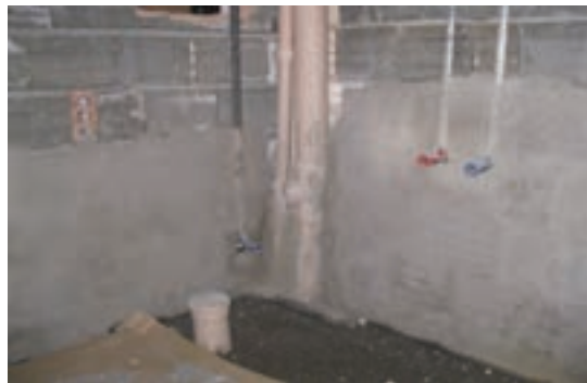
بستر عایق در روی دیوار هم مانند کف باید با ملات ماسه سیمان لیسهای اجرا می‌شود.
