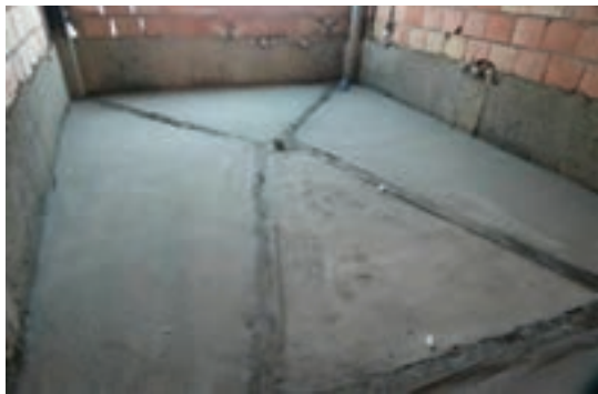
اجرای کرم و بتن شیب‌بندی حمام
