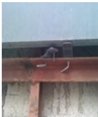
اتصال قطعات زیرسازی سنگ به دیوار
