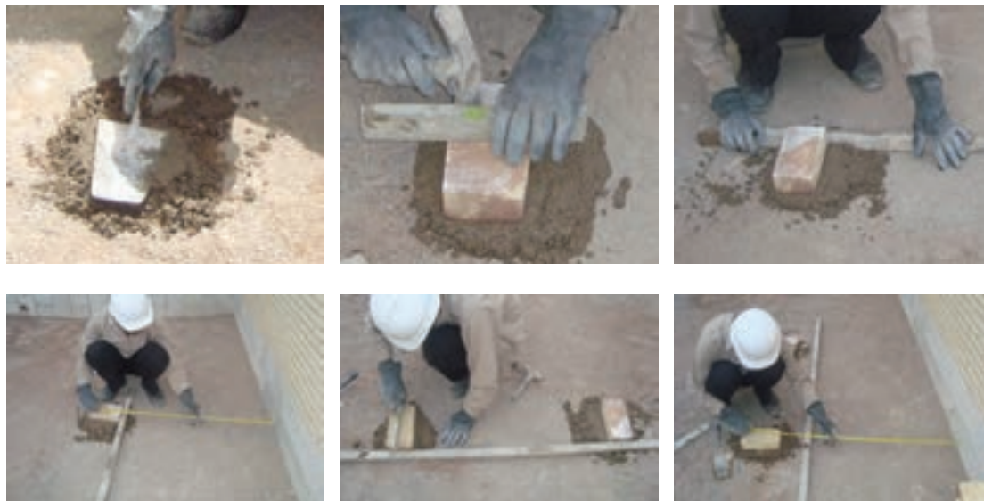
مراحل تعیین محل جداکننده
