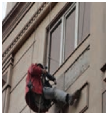
جدا شدن سنگ در صورت اسکوپ نشدن
