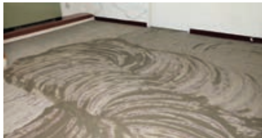
ریختن دوغاب سیمان روی کف و یکدست کردن سطح درزها و کف موزاییک‌ها
