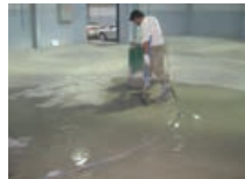
اجرای ملات برای مسطح کردن سطح
