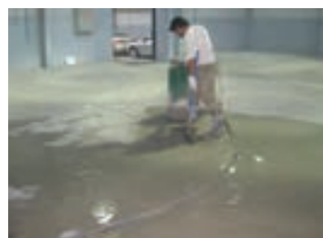
اجرای ملات برای مسطح کردن سطح
