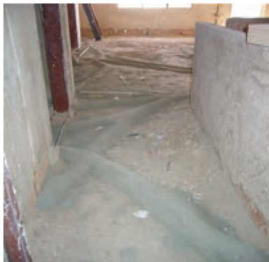
پوشش تأسیسات به منظور محافظت از آنها
