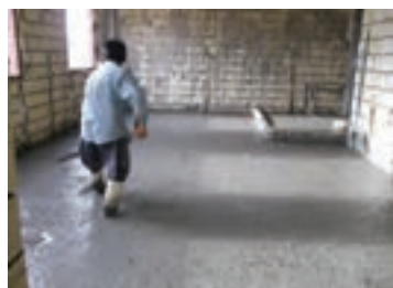
تسطیح فوم بتن قبل از خشک شدن
