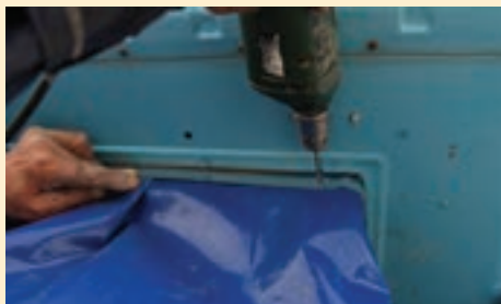
اتصال کانال توزیع هوا به دهانه کولر
