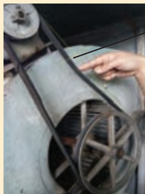
آزمایش سفتی تسمه
