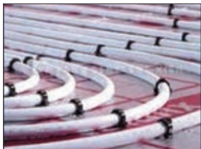
لوله کشی با لوله های ترموپلاستیک
