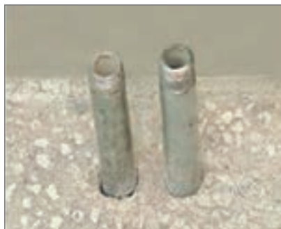
شکل لوله رفت و برگشت در کف
