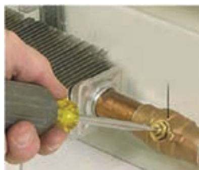
شیر هواگیری کنوکتور
