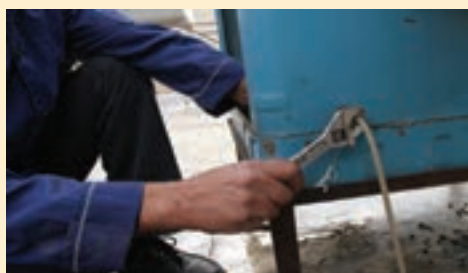
نصب لوله به شیر شناور
