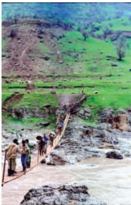
نمونه‌هایی از طرح و اجرای پل نفر رو
