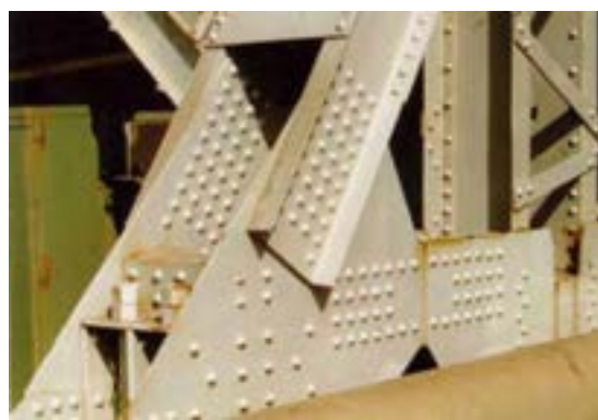
الف) شکل ۳-۱۸ سازه فلزی اتصال پرچی
