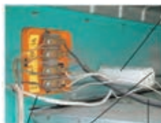
کابل رابط سه سیمه ی خازن اصلاح ضریب سیم رابط پمپ موتور دو دور قدرت آب
