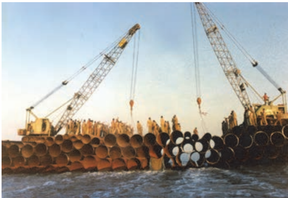
شکل ۱۱-۵- پل بعثت در حال ساخت
