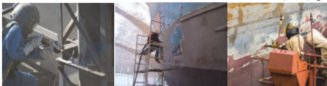
شکل ۱-۷ زنگ‌زدایی در اسکله خشک
