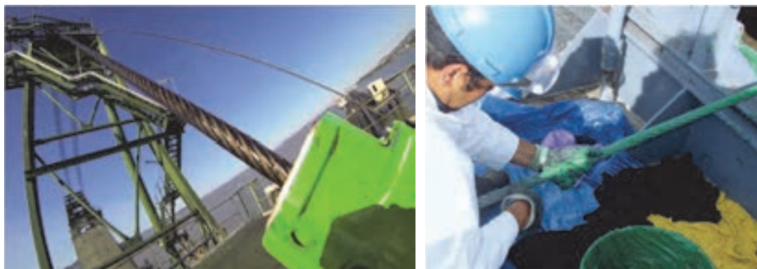
شکل ۲۲-۱ روان کاری طناب سیمی با گریس
