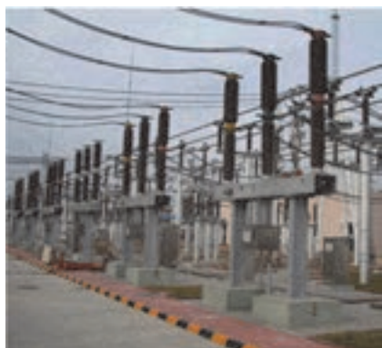
شکل ۱۸- کلید گازی \text{SF}_6
