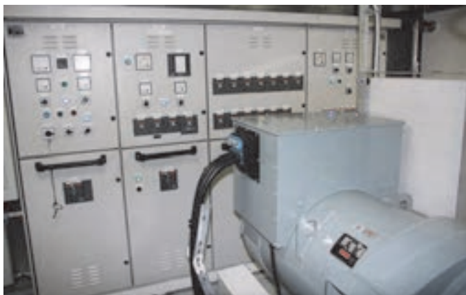
شکل ۱- تولید و توزیع برق شناور
