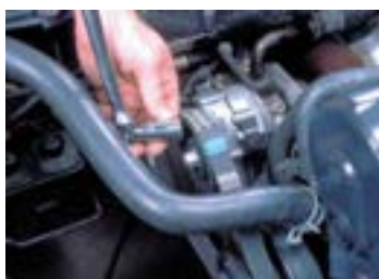
۹- پیچ تسمه سفت‌کن یا پایه آلترناتور سفت شود و عملکرد تسمه بررسی شود.
