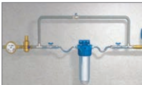
شکل ۶ - روش نصب سختی گیر پلی فسفات
