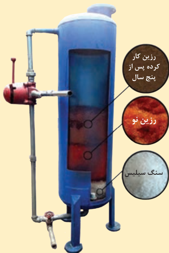
نمای برش خورده و مقدار سیلیس و رزین سختی‌گیر رزینی
