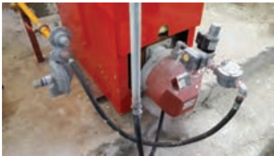
شکل ۲۹- اتصال مدار سوخت
