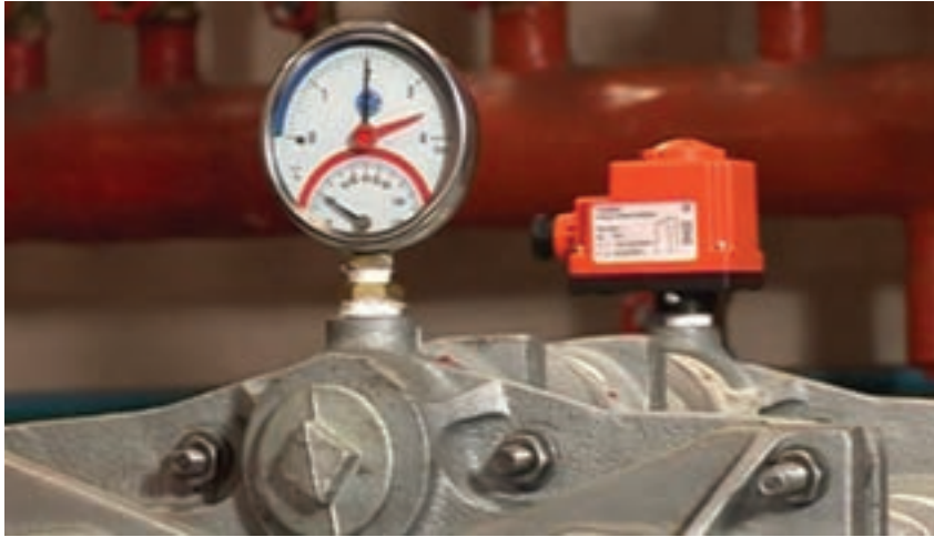
شکل ۲۱- نصب کنترل کننده و نشان دهنده دیگ
