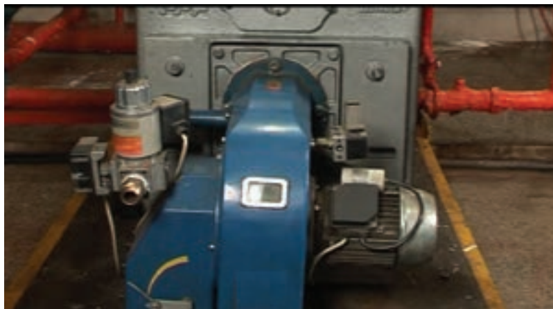
شکل ۲۷- نصب مشعل روی دیگ
