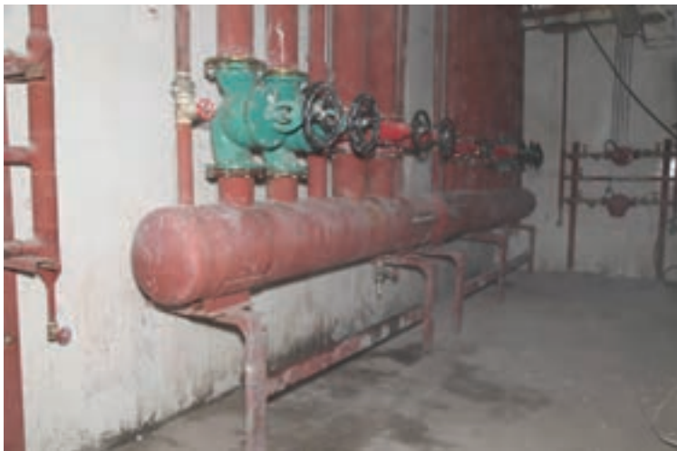
شکل ۱- نصب شیر تخلیه کلکتور
