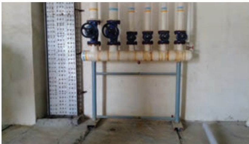
شکل ۲- نصب پایه کلکتور
