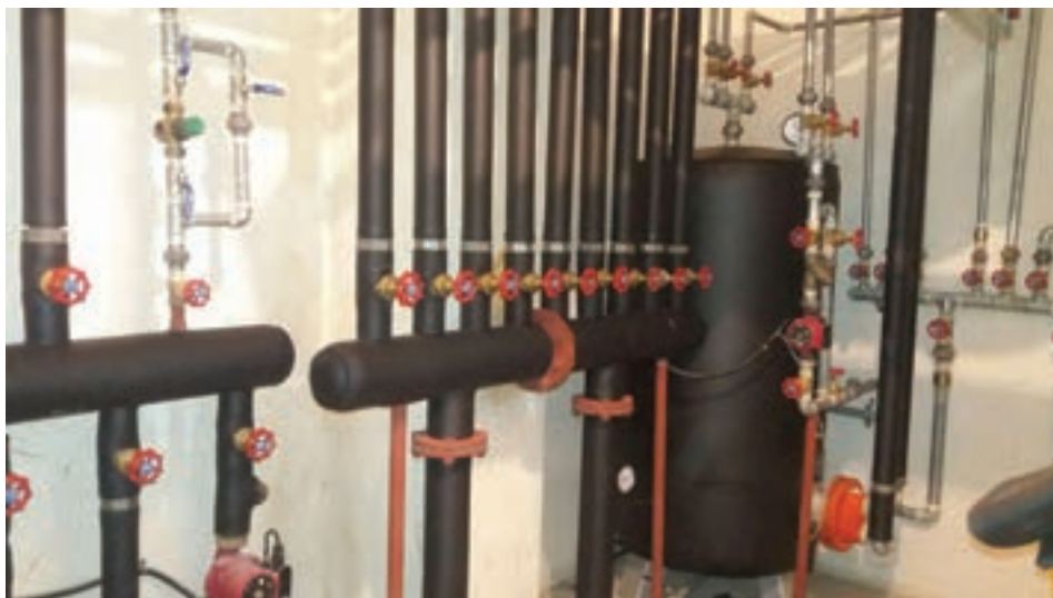
شکل ۲۵- عایق کاری در موتورخانه
