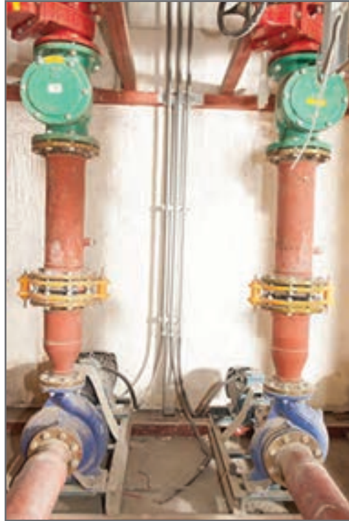
شکل ۳۲ - خط رانش پمپ زمینی
