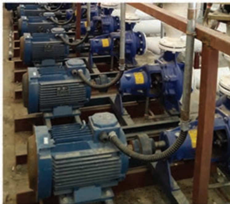
شکل ۲۴- اتصال موتورهای سه فاز
