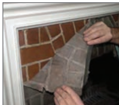
شکل ۲۱- دوده‌زدایی مکانیکی به روش برچسب پاک کننده
