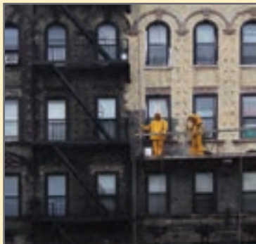
دوده زدایی بر روی نمای ساختمان
