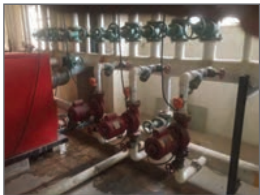
شکل ۱ - پمپ سیر کولاتور سیستم گرمایی
