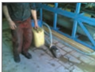
شکل ۲۵- مسیر ارتباطی پمپ و شلنگ به مبدل و بشکه اسید (پراتور آماده افزودن دیسکیلر به بشکه است)
