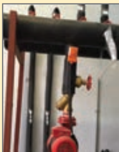
ترموستات جداری نصب روی عایق گرمایی
